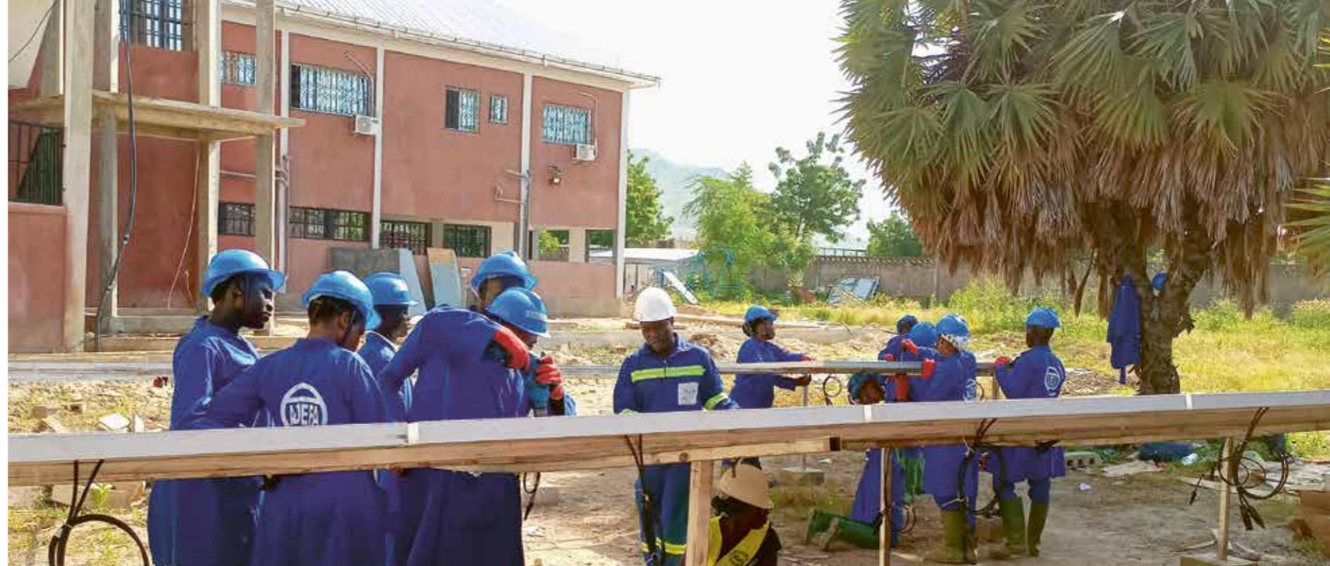
Unter Anleitung erfolgt die Montage der Solarpaneele. © WeeY - Energies et Eaux
